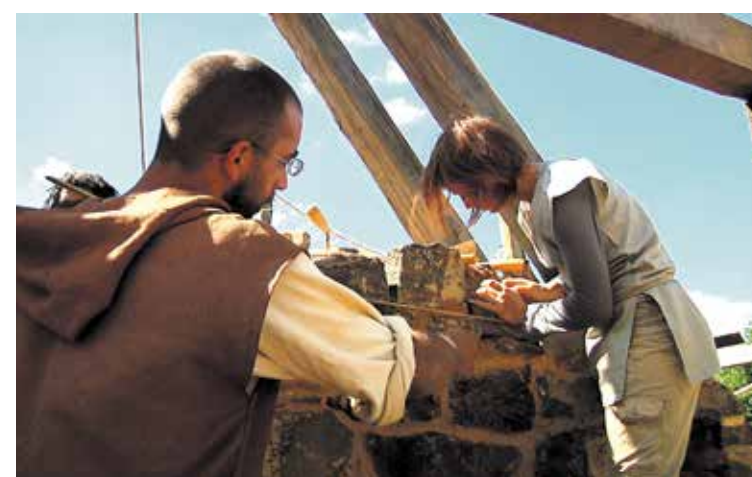
* Meester en gezel aan het werk op de historische bouwplaats van Château Guédelon in Frankrijk (foto Ruud van der Heiden).
