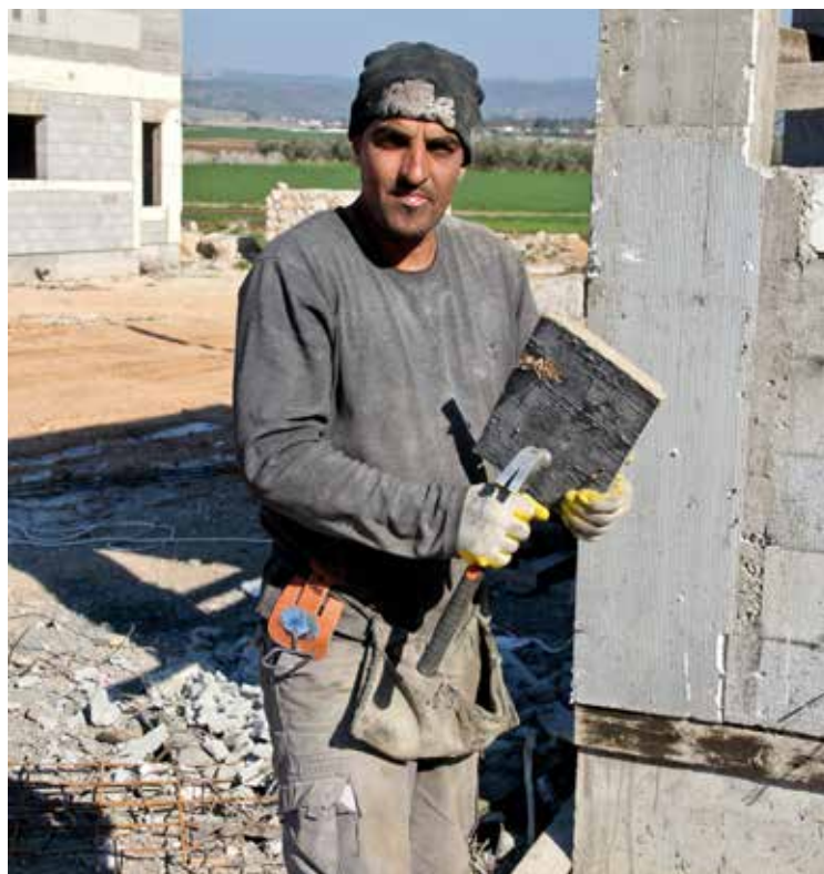
* Bouwwerkzaamheden in Nes Ammim (foto Gerard Geitenbeek).
